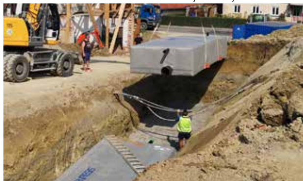
Nopea asentaa työmaalla
