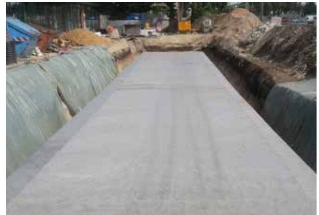
Sammutusvesisäiliö 420 m 3 , EASY Credit, Nürnberg
