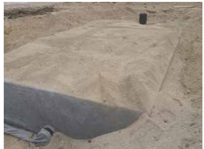
Sammutusvesisäiliö 2 x 100 m 3 , Röser Medical, Essen
