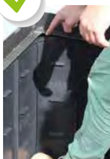
Levyt tulisi asentaa mahdollisimman lähelle istutuskuopan reunoja, jotta puulle jää mahdollisimman suuri tila.
