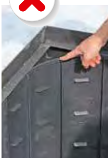
Levyt tulisi asentaa mahdollisimman lähelle istutuskuopan reunoja, jotta puulle jää mahdollisimman suuri tila.
