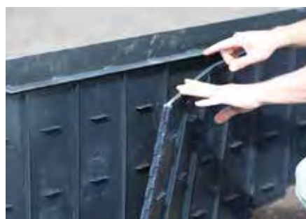
Levyt voidaan asentaa tarvittaessa myös limittäin.
