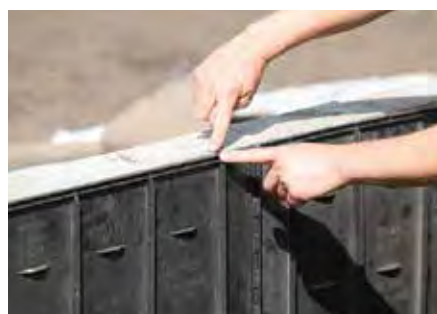
Levyn yläreuna asennetaan kasvualustan pinnan yläpuolelle.
