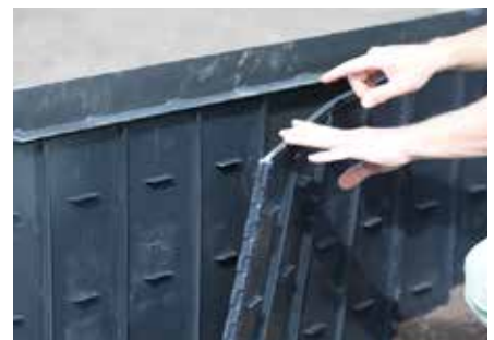
Levyt voidaan asentaa tarvittaessa myös limittäin.
