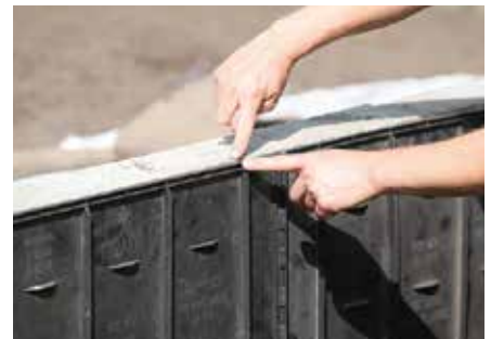
Levyn yläreuna asennetaan kasvualustan pinnan yläpuolelle.
