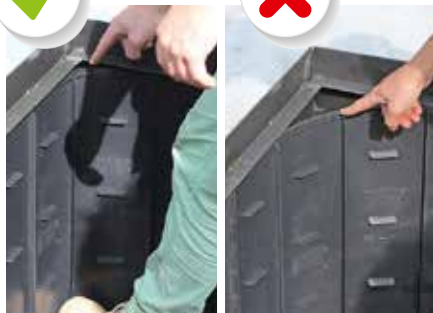
Levyt tulisi asentaa mahdollisimman lähelle istutuskuopan reunoja, jotta puulle jää mahdollisimman suuri tila.
